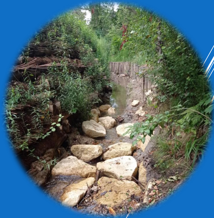
Travaux de confortement des berges du ruisseau du Fontaudin à Artigues-près-Bordeaux
