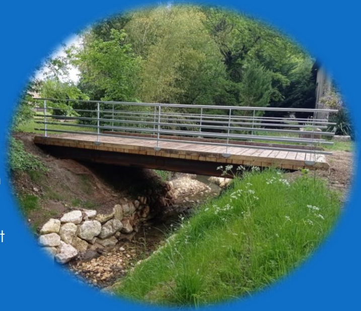
Finalisation des Travaux de restauration de la continuité écologique à Sainte-Eulalie
